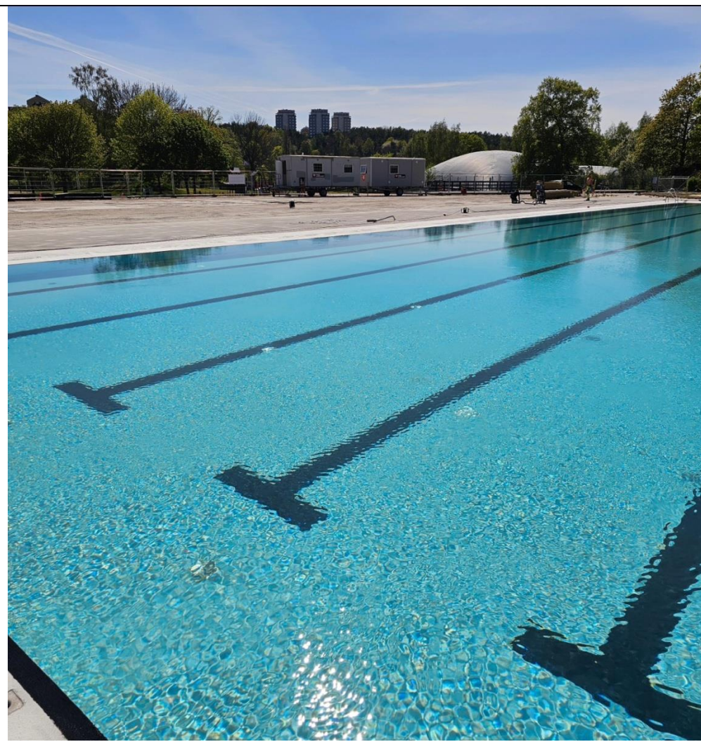
RENOWACJA BASENU ODKRYTEGO W SYSTEMIE ECO SILICATE
