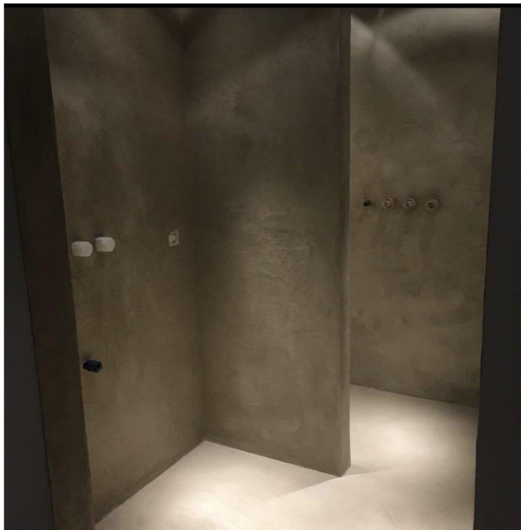
REALIZACJA W SYSTEMIE ECO RAPID DECO
