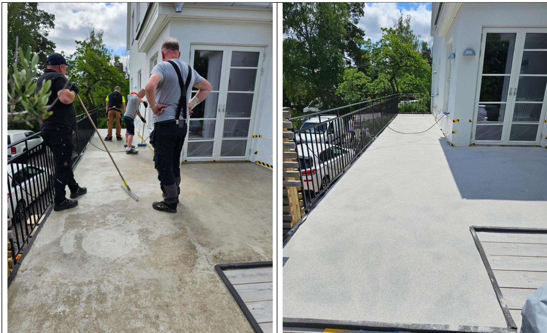
REALIZACJA TARASU DEKORACYJNEGO W SYSTEMIE ECO RAPID INDU
