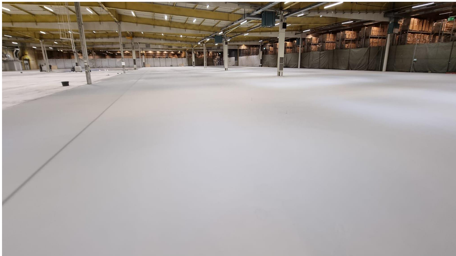
CENTRUM DYSTRYBUCYJNE W SYSTEMIE ECO SILICATE: ECO PRIMER + ECO RAPID SL + ECO TOPCOAT MAT
